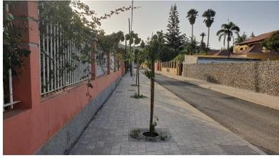
*Figura 3: los vados peatonales no han sido ejecutados, rebajando el borde de la acera a la rasante de la calzada (una vez esté echada la capa fina de asfalto).*
