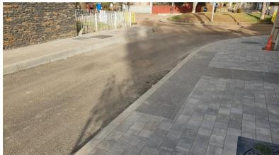
*Figura 7: este punto es en la Rotonda donde nace la Calle Concepción Salazar, en la que aparece el vallado de la obra, en la que se puede observar el rebaje del bordillo para hacer el vado peatonal, como la implantación de diferente trama de acerados para las personas con discapacidad visual.*
