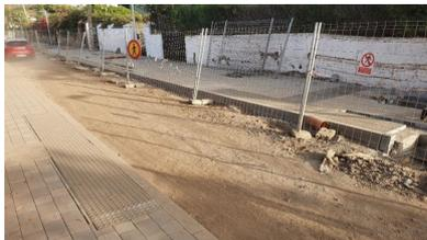
*Figura 6: se observa la ausencia de previsión en la ejecución de los vados.*
