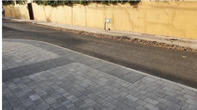
*Figura 4: Igualmente, en la acera de enfrente, se observa que la pendiente que supondrá la ejecución del vado peatonal, tendrá una vertiente superior a 1,5 %.*
