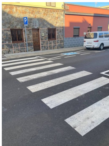
Geneto. Aceras interrumpidas, sin rebajes y firme en malas condiciones. Calle Bocatuerta, Inmediaciones Colegio Echeyde.
