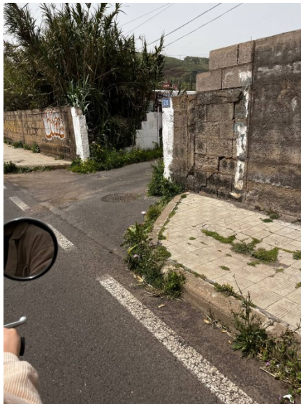
Geneto. Aceras interrumpidas, sin rebajes y firme en malas condiciones. Calle Bocatuerta, Inmediaciones Colegio Echeyde.
