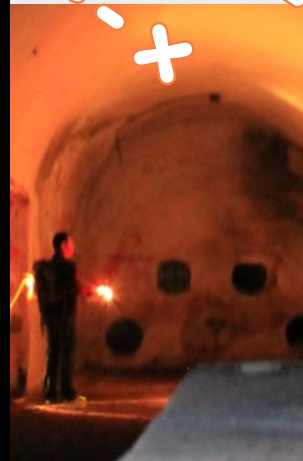
Detalle de las galerías. Foto: Tomás Rodríguez
