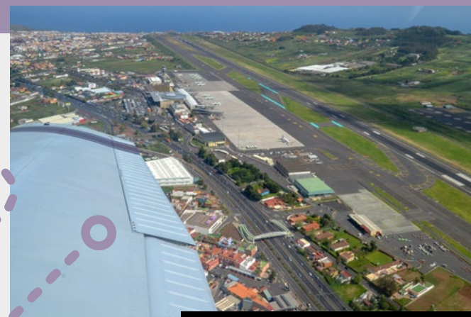
Pista del aeropuerto Tenerife Norte
