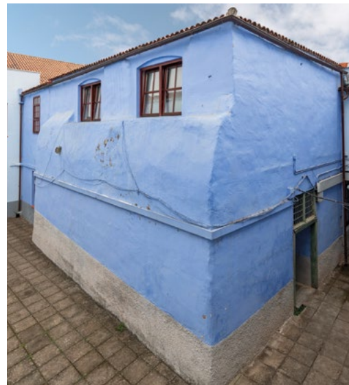
Antigua cárcel municipal
