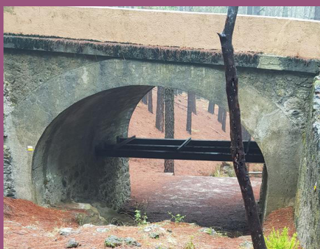
Paso por el túnel.
