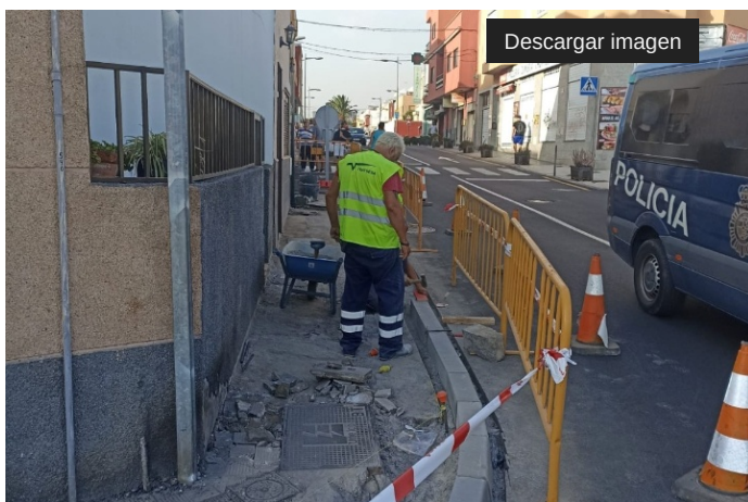
Ampliación de aceras
