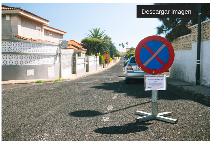
Repavimentación y mejora del firme de la calle Ucanca
