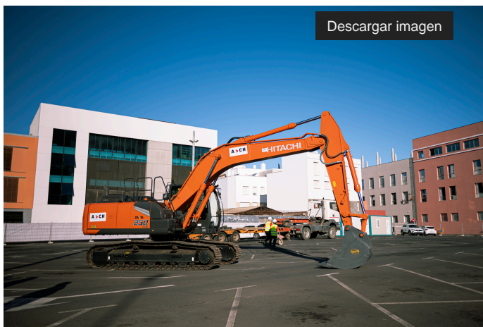
Trabajos de canalización del barranco de la Carnicería
