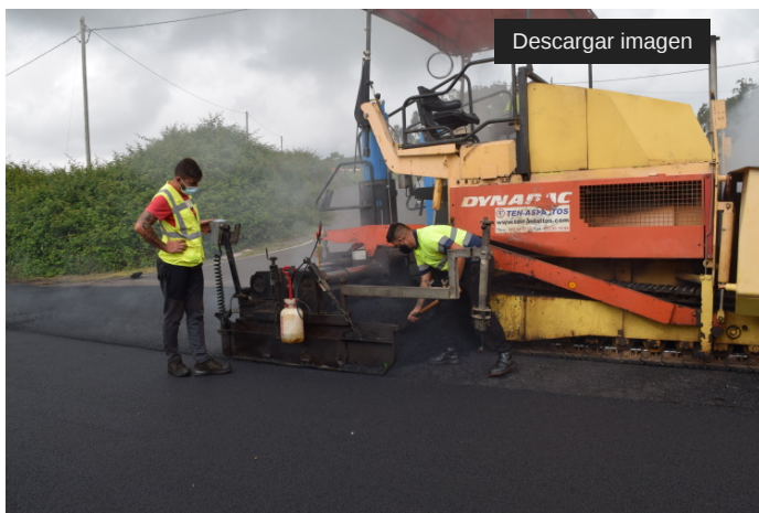
Obras de asfaltado en La Laguna
