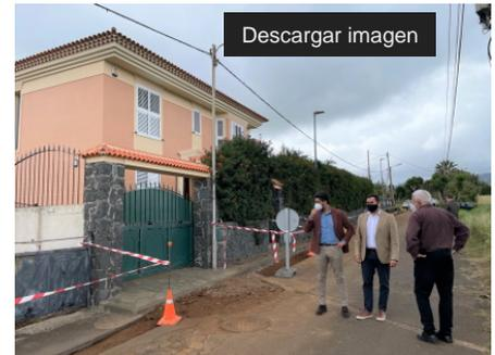
La empresa adjudicataria del mantenimiento de alumbrado público en el municipio, Efficó, ha comenzado los trabajos de apertura de zanjas y canalizaciones para sustituir los puntos de luz obsoletos de vapor de sodio por LED Ámbar. Esta tecnología, según detalló el concejal, se colocará en un total de 25 puntos, “por ser menos contaminante e implicar un menor consumo eléctrico, lo que redundará también en un ahorro económico para las arcas públicas”.
