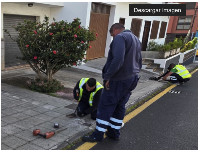
Trabajos en El Coromoto
