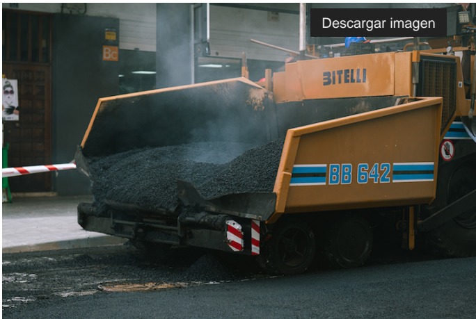
Obras de Asfaltado en La Laguna
