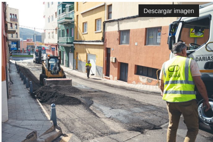
Trabajos de asfaltado en La Laguna
