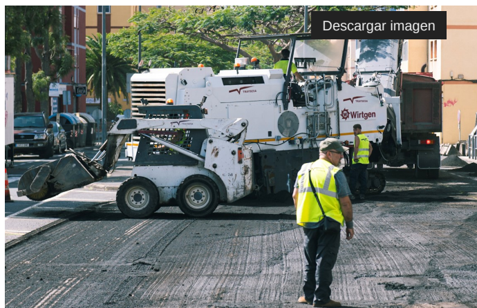
Obras de Asfaltado
