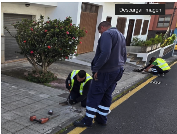
sustitución de las líneas eléctricas deterioradas del alumbrado público
